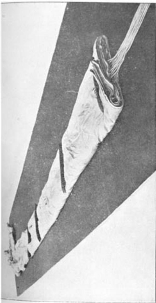
Obr. 11. Vrchlík padáku jest upraven k složení do obalového dílce.
